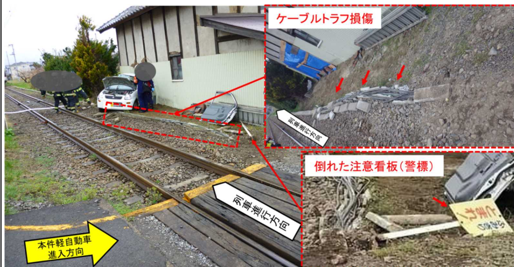
図7 鉄道施設の損傷状況
