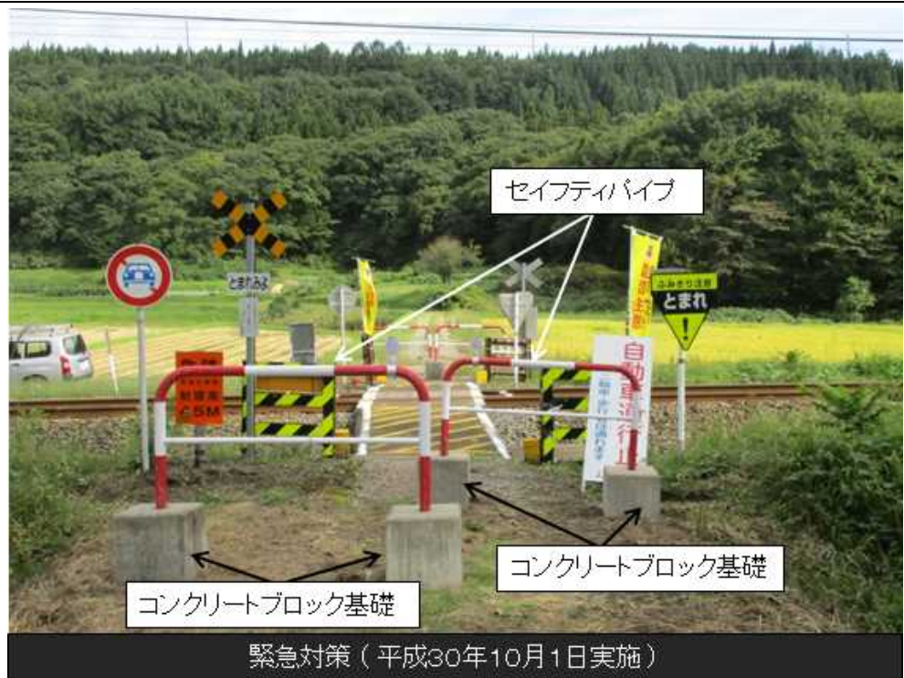
図 1 1 セーフティパイプとコンクリートブロック基礎設置後の本件踏切
