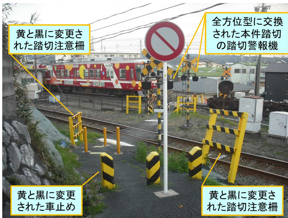
図10 措置後の本件踏切の様子（令和2年3月16日時点）
