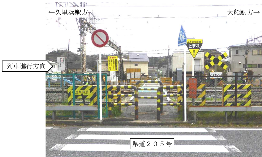
図9 本件踏切を北側から撮影 [H]
