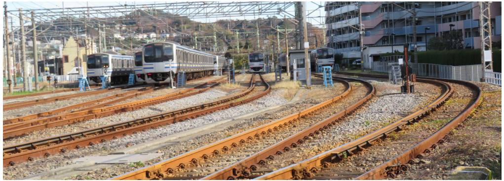
図6 本件踏切の南側から留置線の見通し C (事故後に撮影)
