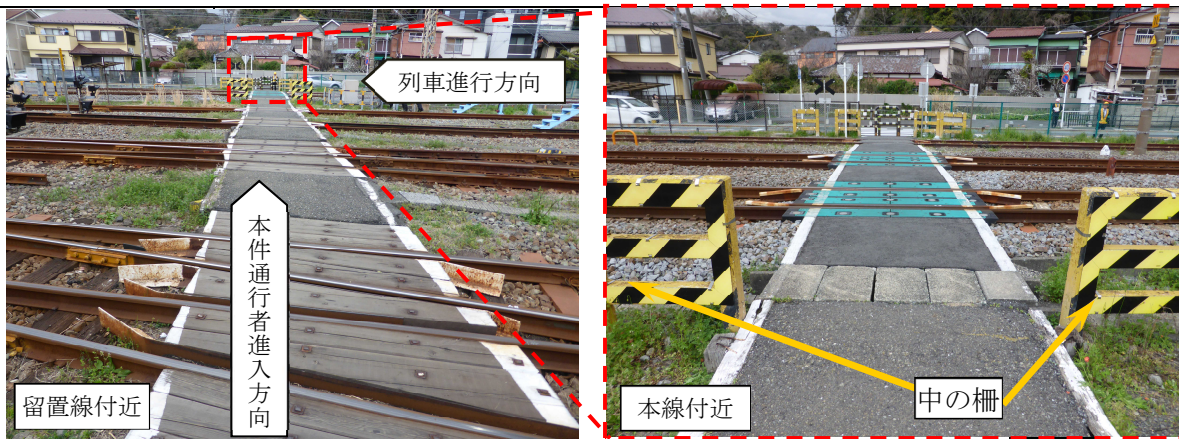
図4 本件踏切内の南側（本件通行者進入側）から撮影 [A, D]
