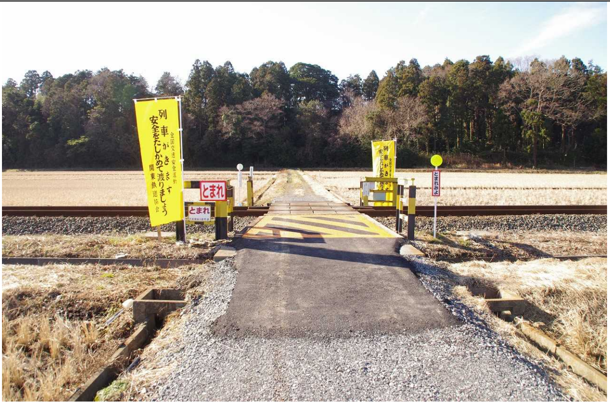
図8 措置後の本件踏切の様子（令和2年1月時点）
