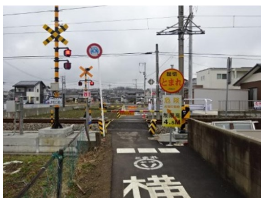
[a] 南側（本件通行者進入側）から撮影
