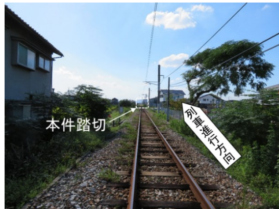
図7 下り列車（道上駅方）側から見た本件踏切の見通し状況 （本件踏切の約200m手前から撮影）
