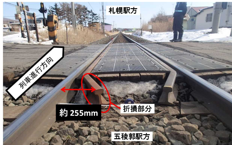
図6 入江町踏切道のガードレールの折損部分（復旧後）
