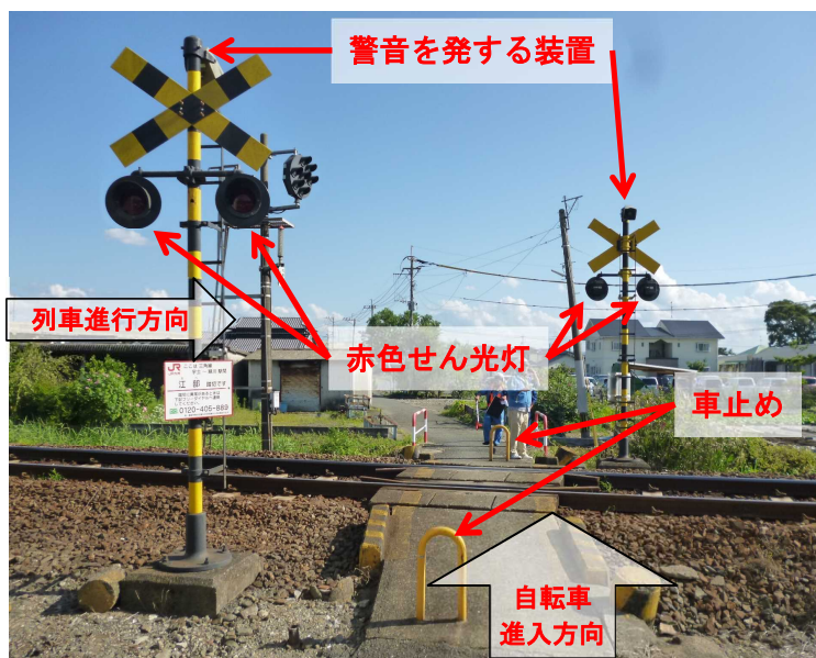
写真1 本件踏切周辺の状況
