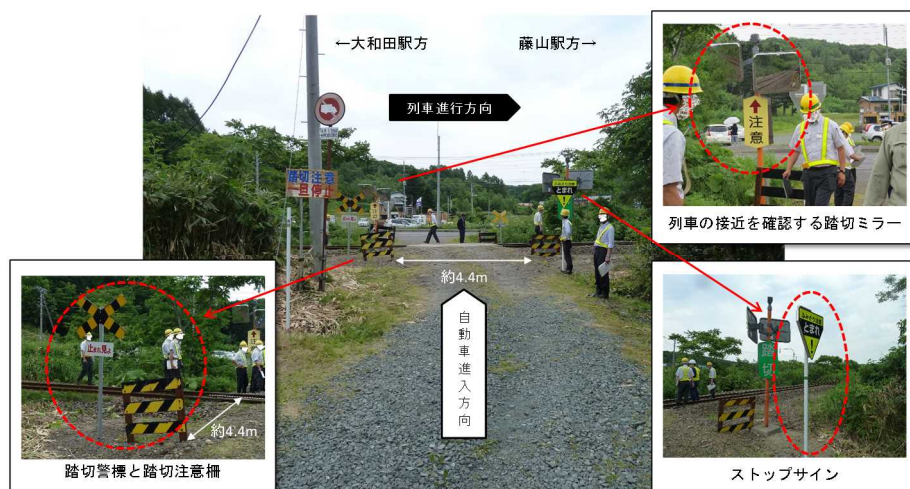
写真1 本件踏切の状況
