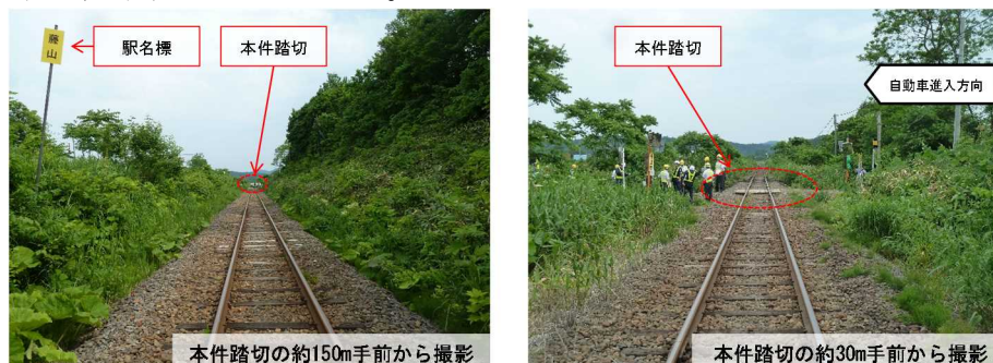
写真2 列車側から見た本件踏切の見通し
