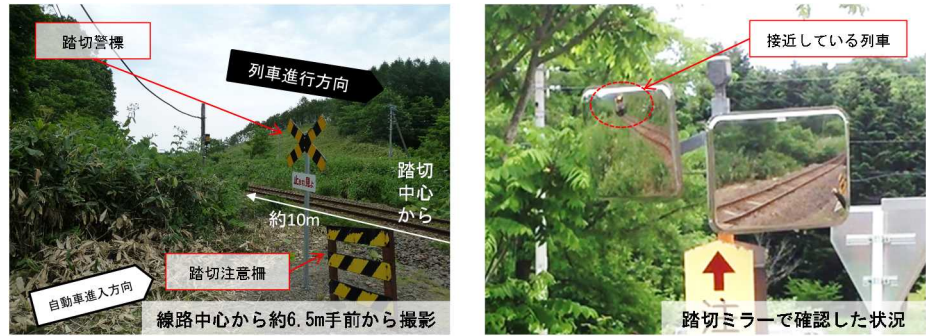
本事故発生日翌日に本件列車と同時刻の列車で確認
