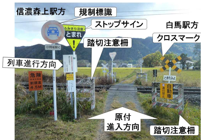
写真1 本件踏切の概観（原付進入側から撮影）
