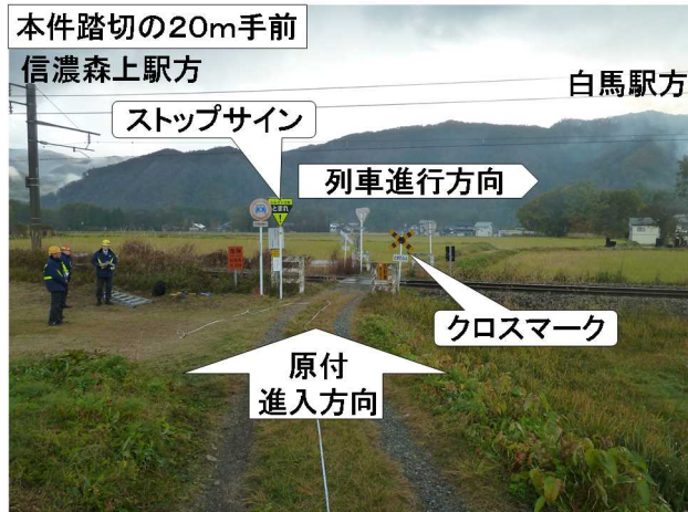
写真3 原付進入側から見た本件踏切の見通し状況
