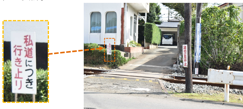
写真5 本件道路から本件踏切正面を撮影（左手奥の“私道につき行き止り”の看板は私有地所有者が設置。写真手前やや右手の“踏切一旦停止”の文字掲示物は同社が設置。本事故翌日現地調査にて撮影）
