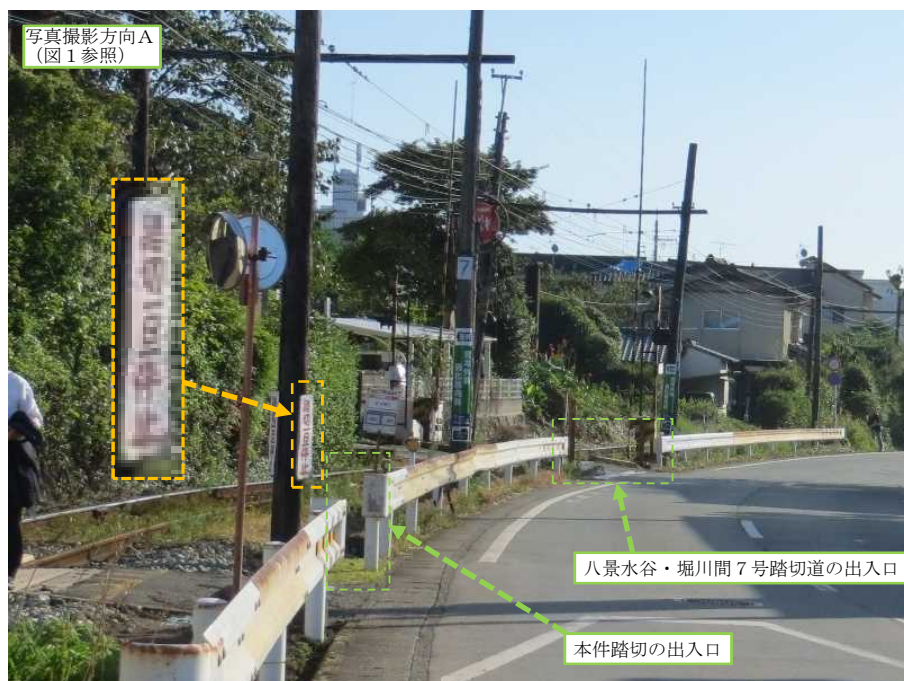
写真3 本件道路（堀川駅寄り）から本件踏切と八景水谷・堀川間7号踏切道（右手奥点線枠囲い箇所）を撮影（本事故翌日現地調査にて撮影）
