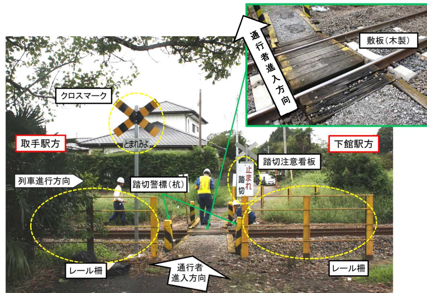
写真1 本件踏切の状況
