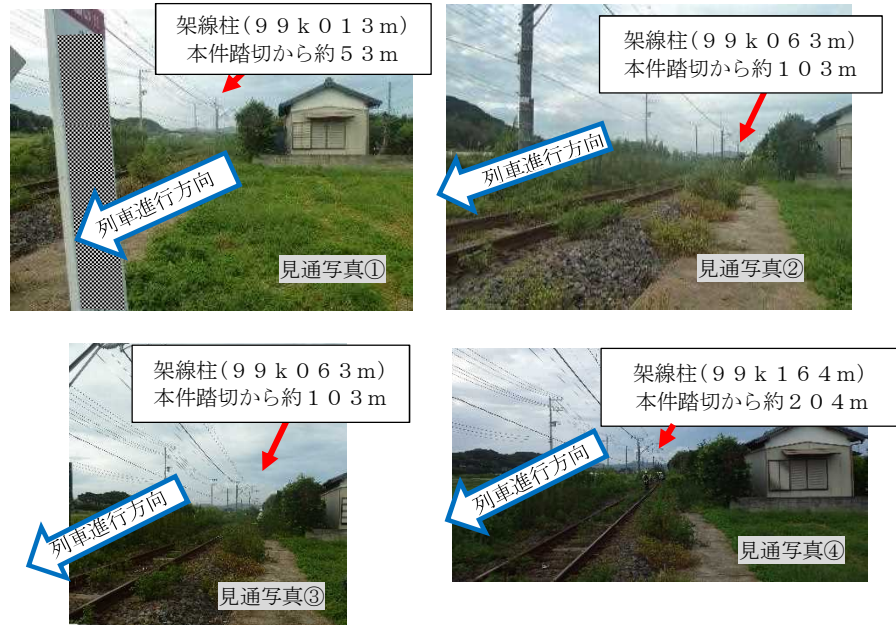
写真3 本件踏切からの南三原駅方の見通し (2.3(6)図3 見通写真①～④の位置で撮影)
