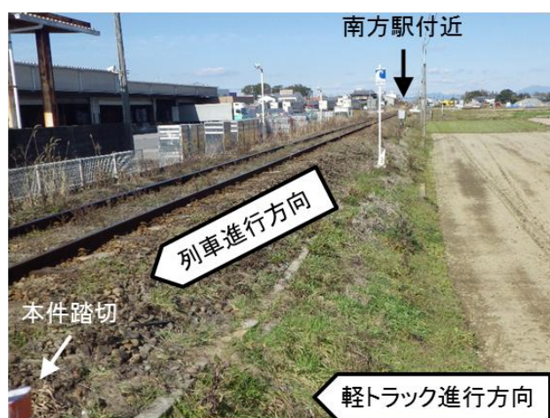
写真6 本件踏切左側の踏切停止線からの見通し
