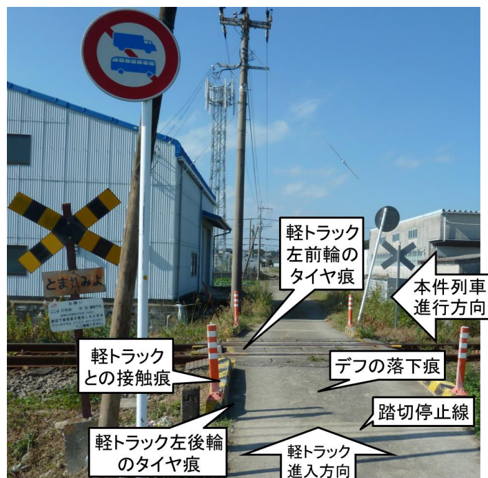
写真1 本件踏切の状況及び軽トラックによるものとみられる痕跡
