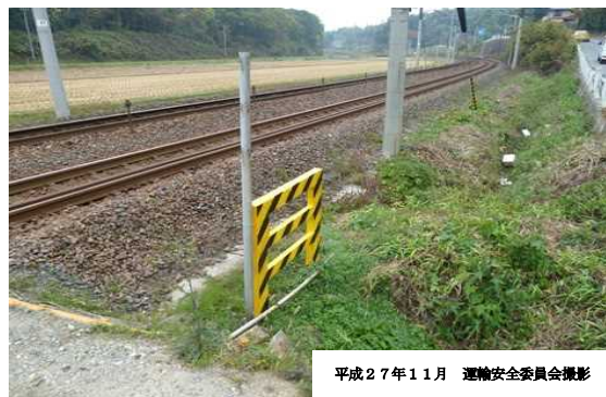
写真2 本件踏切周辺の現状
