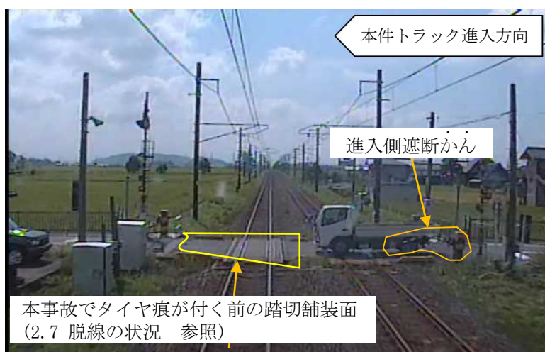
写真3 本件トラックは進入側遮断かんを折り曲げて隣接線まで進入
