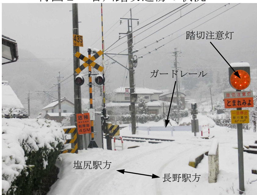
付図2 谷川踏切近傍の状況
