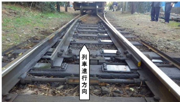
本件分岐器の定位状態（事故後に撮影）
