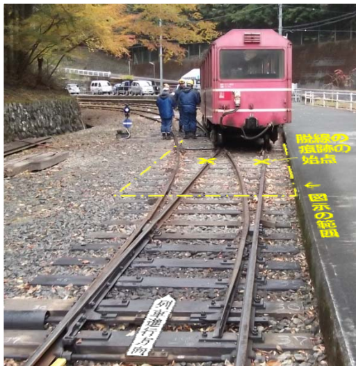
↑ 事故現場 (24号分岐器) 付近の全景
