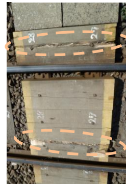
作業用通路損傷 396k537m付近
