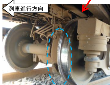
本件車両後台車第1軸 車輪踏面の損傷
