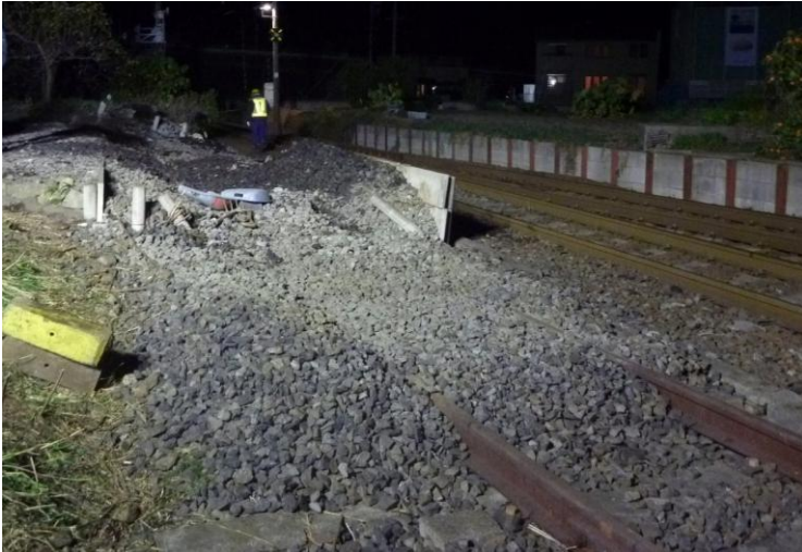
本件列車撤去後
