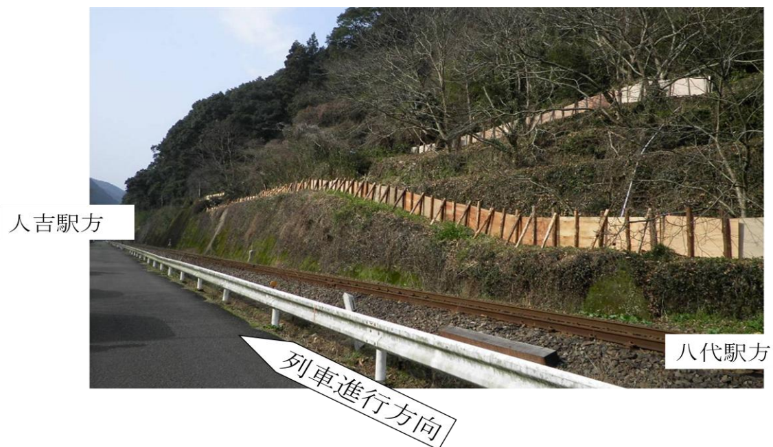
写真 1 0 事故現場付近全景（応急対策後）
