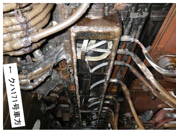
配線ダクトのカバーを開けた状態(後側)
