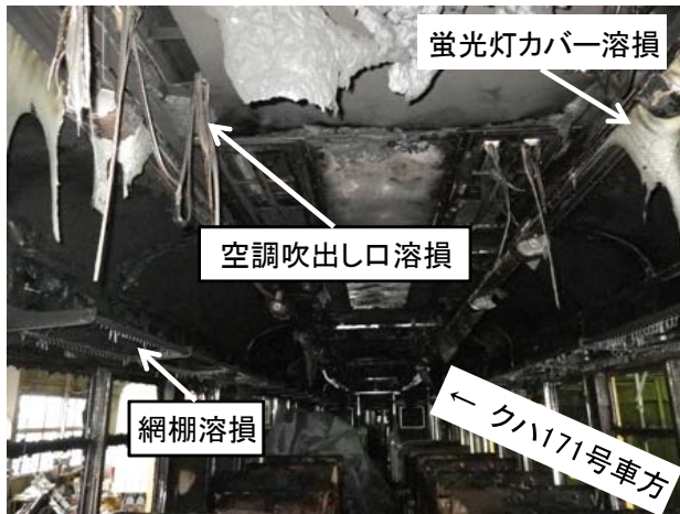
車内の焼損状況
