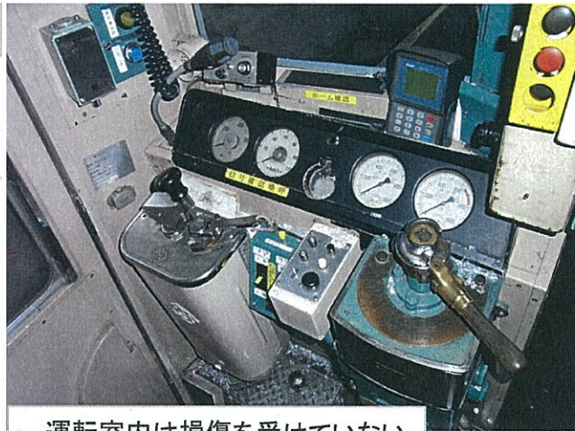
運転室の状況
