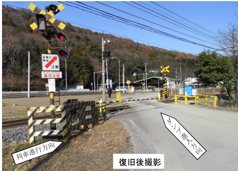
写真1 本件踏切の状況
