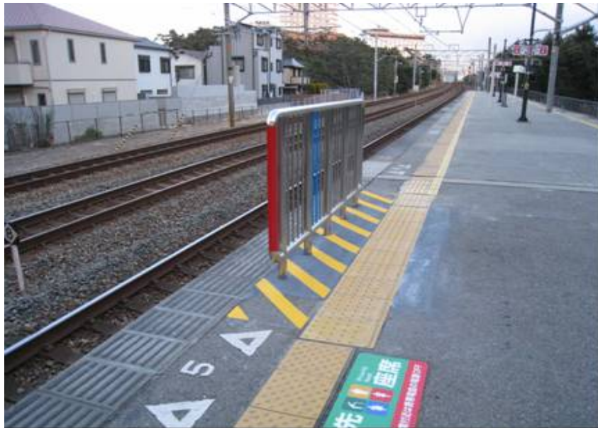
写真3 同駅に設置された固定柵
