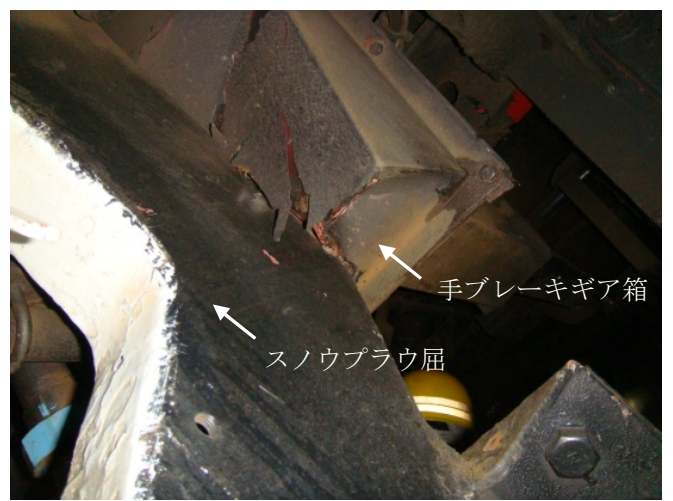
スノウプラウ接触による手ブレーキギア箱潰れ
