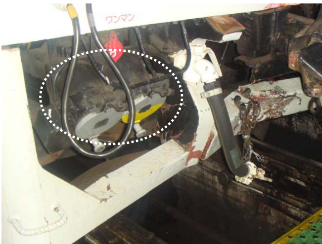
ジャンパー保温器漏水
