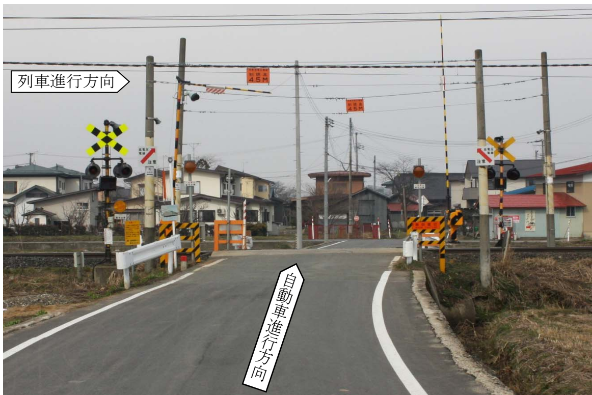
写真1 自動車側から見た本件踏切の状況
