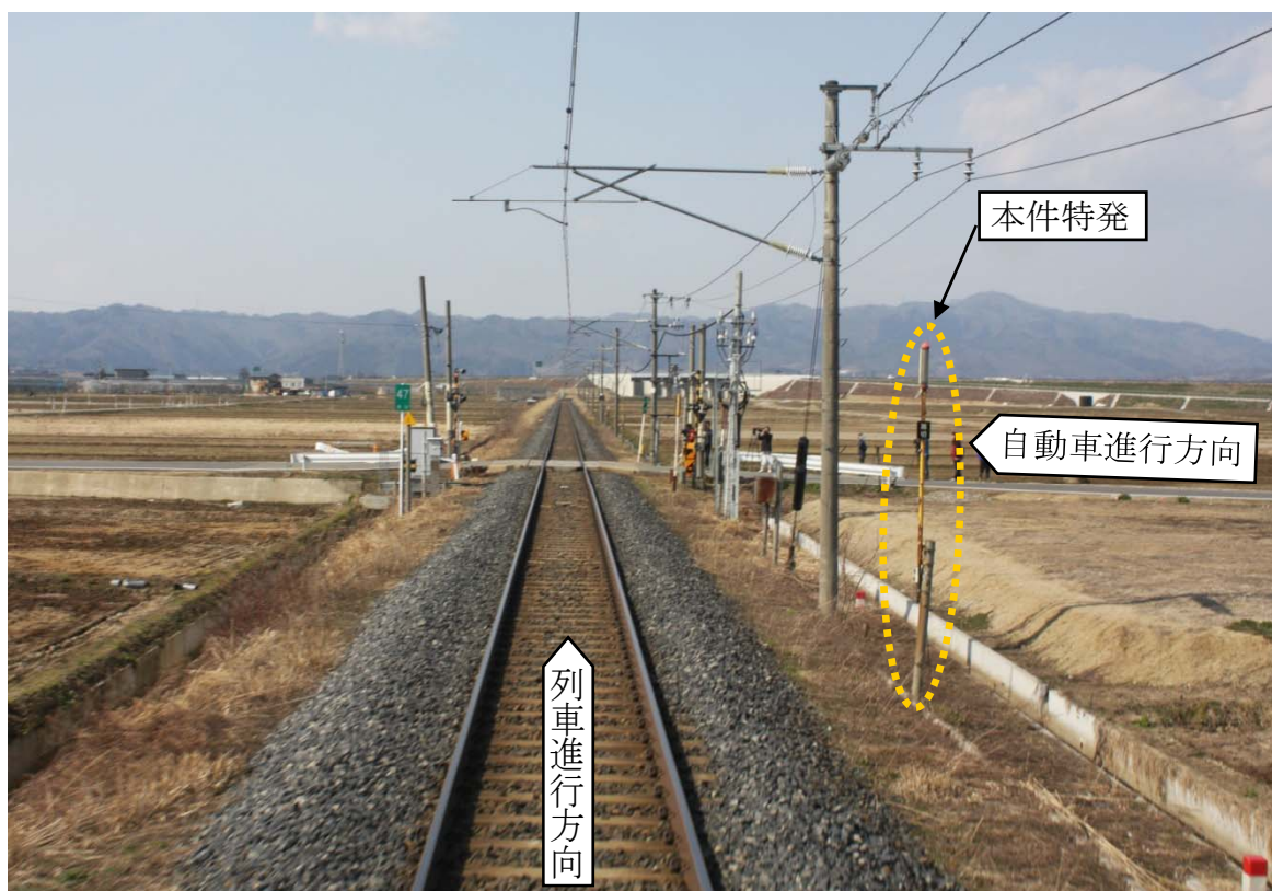
写真2 列車側から見た本件踏切の状況
