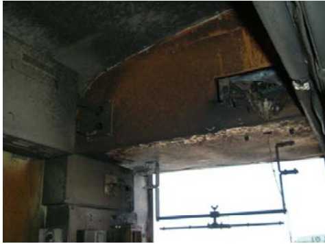
前方運転室天井
