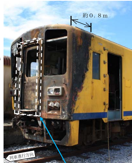
前方左側から見た焼損状況
