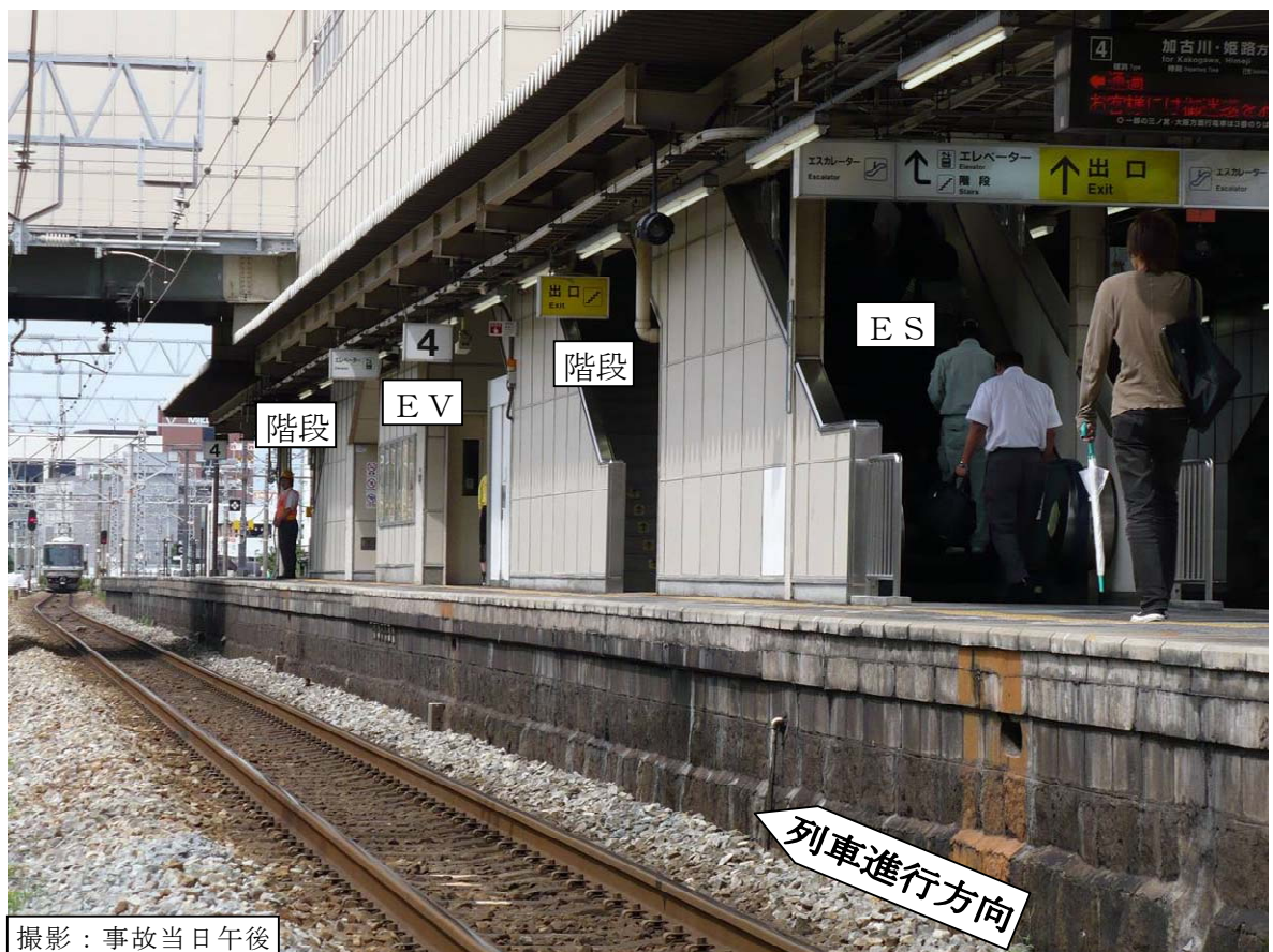
写真2 本事故現場付近
