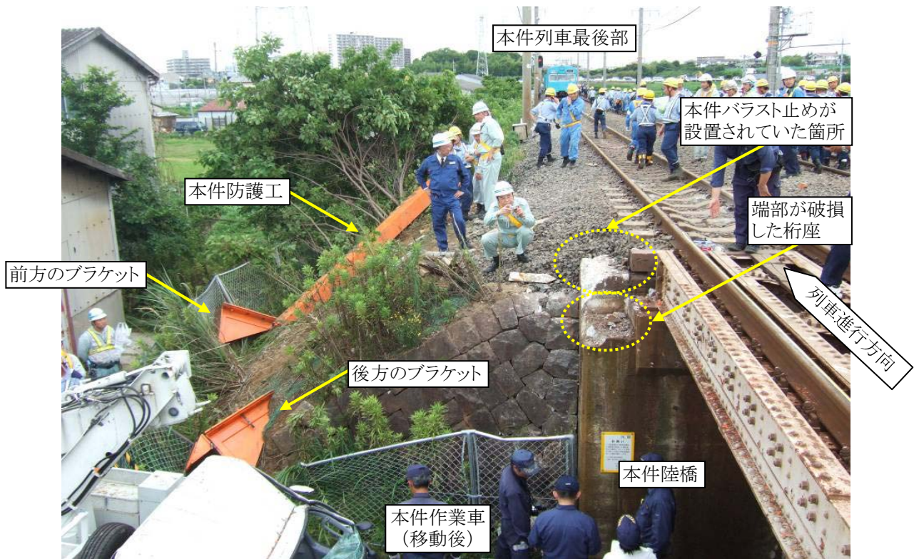
写真5 本件防護工の損傷状況及び痕跡
