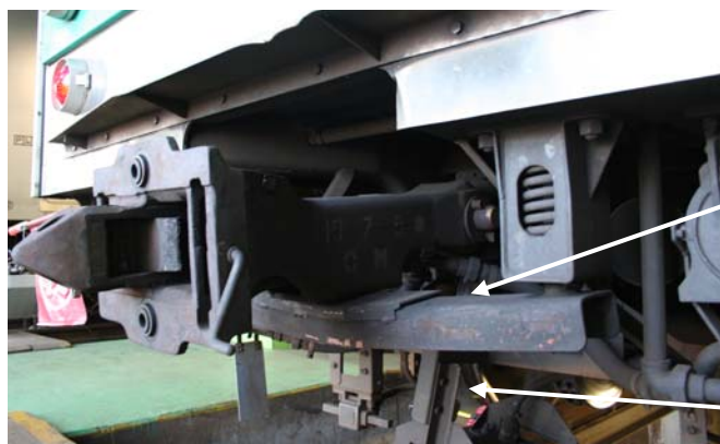
10両目後部 (前面スカートを取り外した状態)
