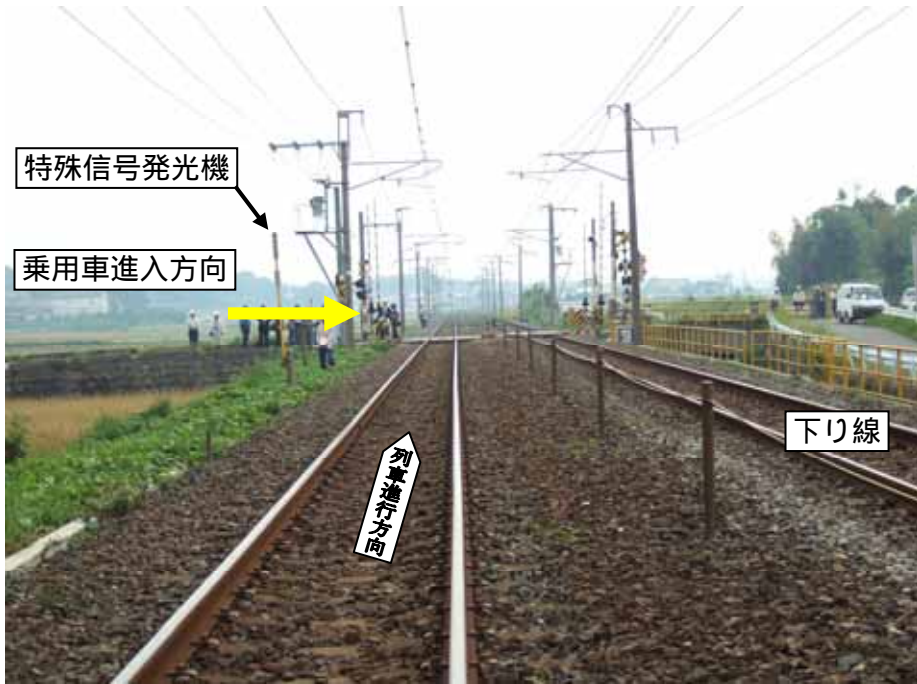
写真1 列車側から見た本件踏切の見通し状況
