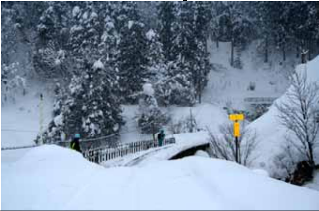
48k186m地点付近(約200m手前)
