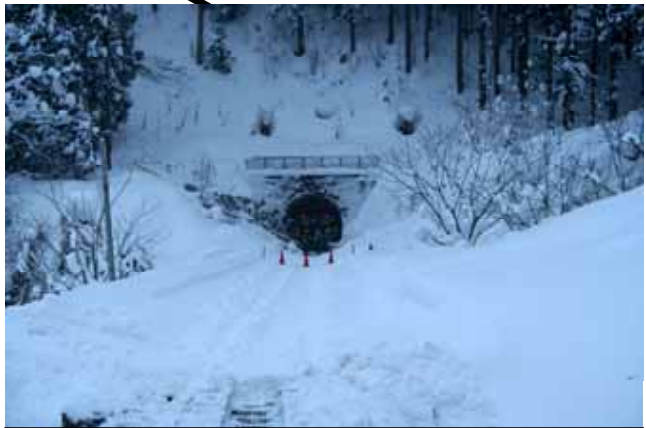
48k275m地点付近(約110m手前)
