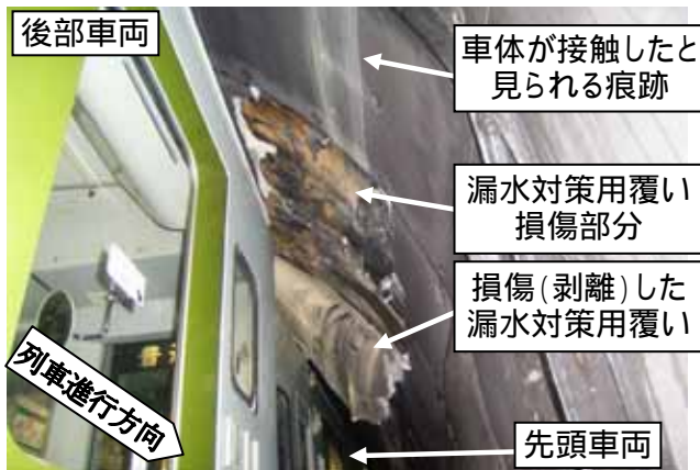
写真3 施設の損傷状況
