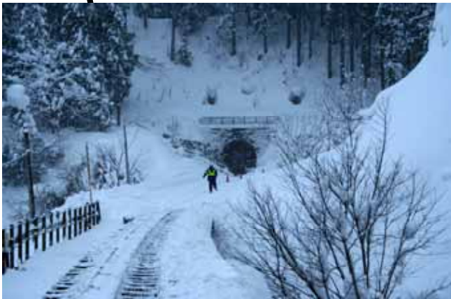
48k223m地点付近(約162m手前)
