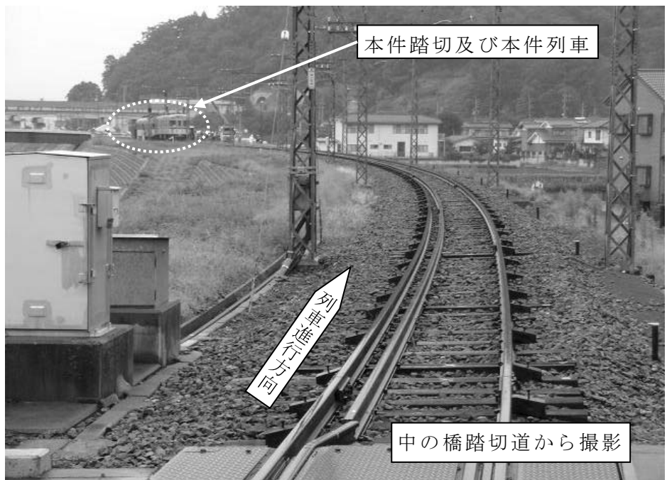
写真2 列車側から見た本件踏切の見通し状況
