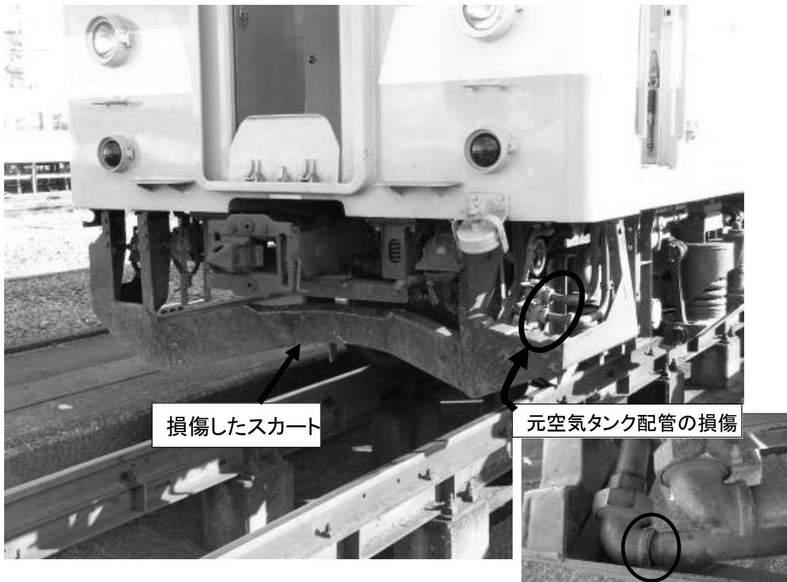
写真3 車両の損傷状況
