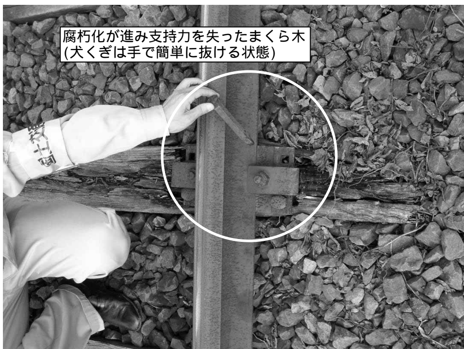
写真8 本件現場と類似の曲線におけるまくら木の状態
