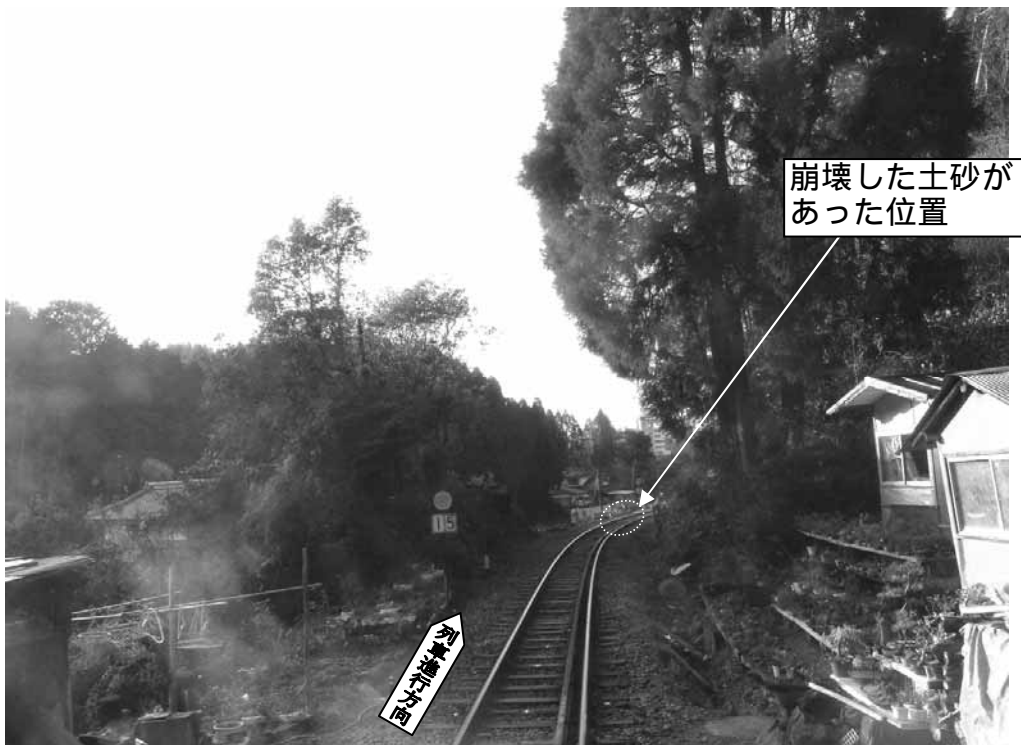
写真3 列車からの見通し（事故後）
