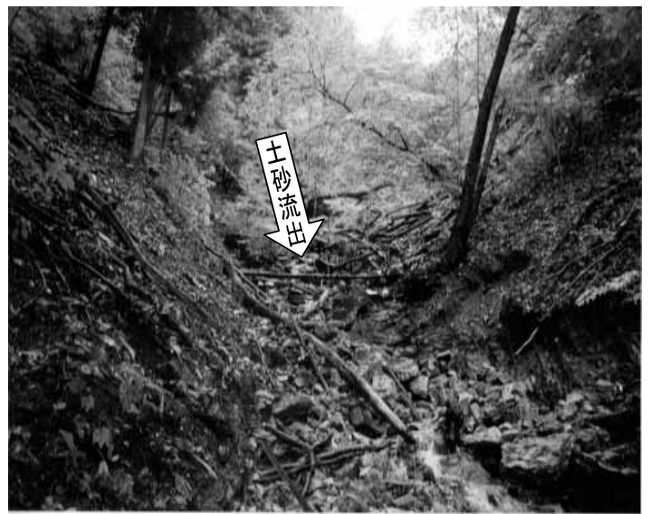
本件土砂流入箇所から上流350m付近
