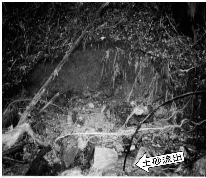
本件土砂流入箇所から上流65m付近
