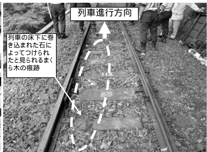
写真9 まくら木の損傷状況
