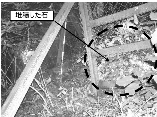
写真8 落石止柵と堆積した石
