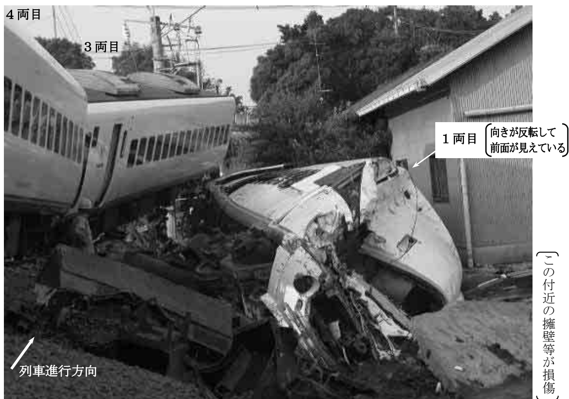
写真1 1両目付近の状況
