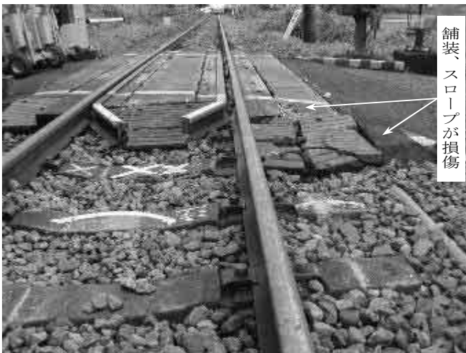
(5) 正久寺第一踏切道(94 k 011m)付近
