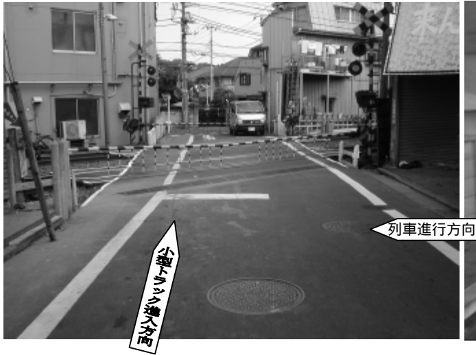
写真1 小型トラック進入側から 本件踏切の見通し状況
