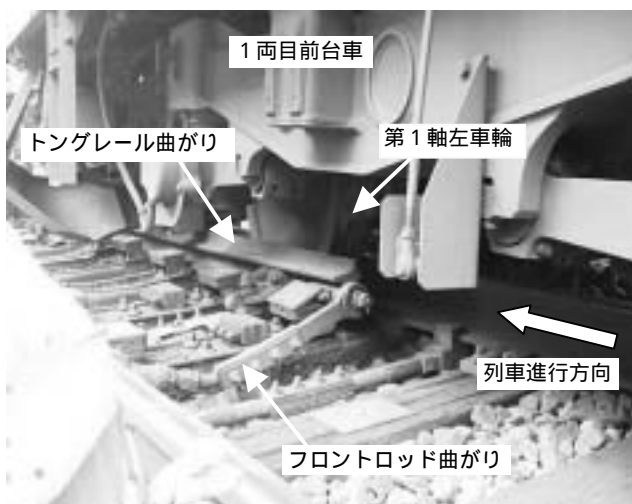
写真5 23号分岐器及び脱線の状況
