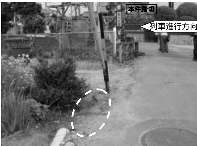
写真5 本事故以前にコンクリート塊があったとされる位置
