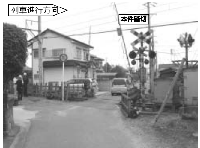
写真4 本事故現場付近の状況
