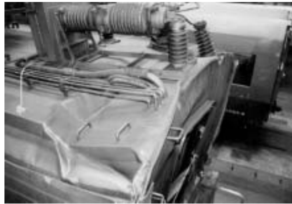
写真C.8 先行列車7両目の前側車端部屋根構体
