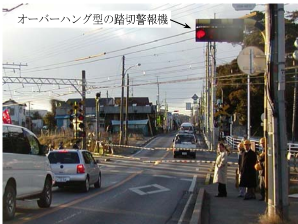
写真3 踏切保安設備の状況
