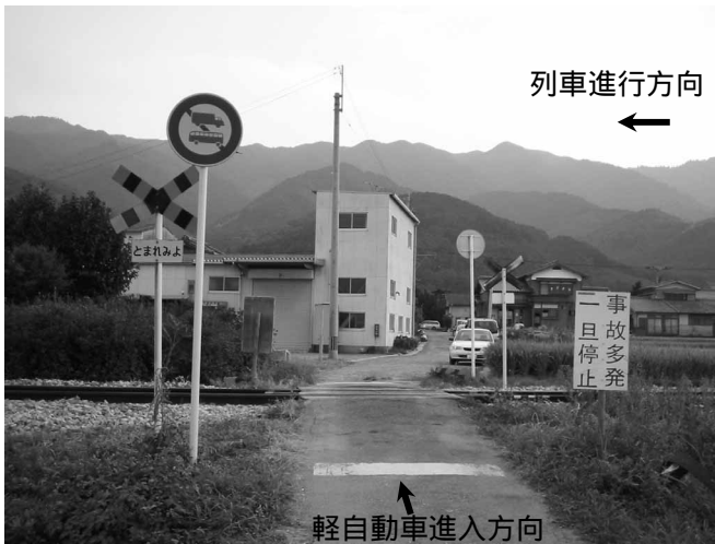
写真1 軽自動車進入側から 本件踏切の見通し状況
