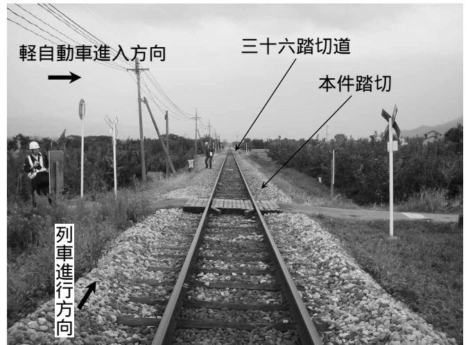
写真2 列車から本件踏切の 見通し状況
