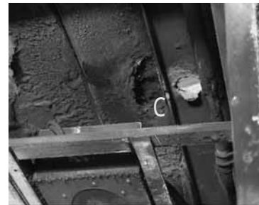
図17 パンタグラフ取付台ボルト部 (屋根裏側)
