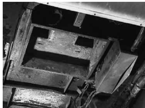
図 25 クーラー下部(ダクト取り外し後)
