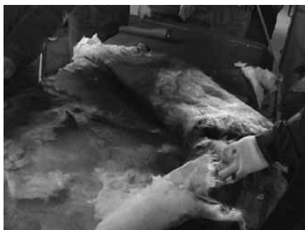
(c) 冷風ダクト上部の断熱材を剥がした状態
