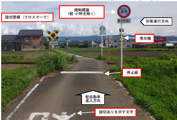
<軽自動車進入側から見た本件踏切の見通し状況>
