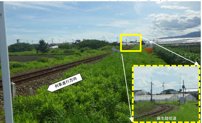
<軽自動車進入側から見た西太刀洗駅方の見通し状況>
