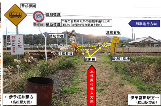
<原付進入側から見た中土踏切道の状況>
