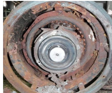
軸受シールドを 取り外した状態
